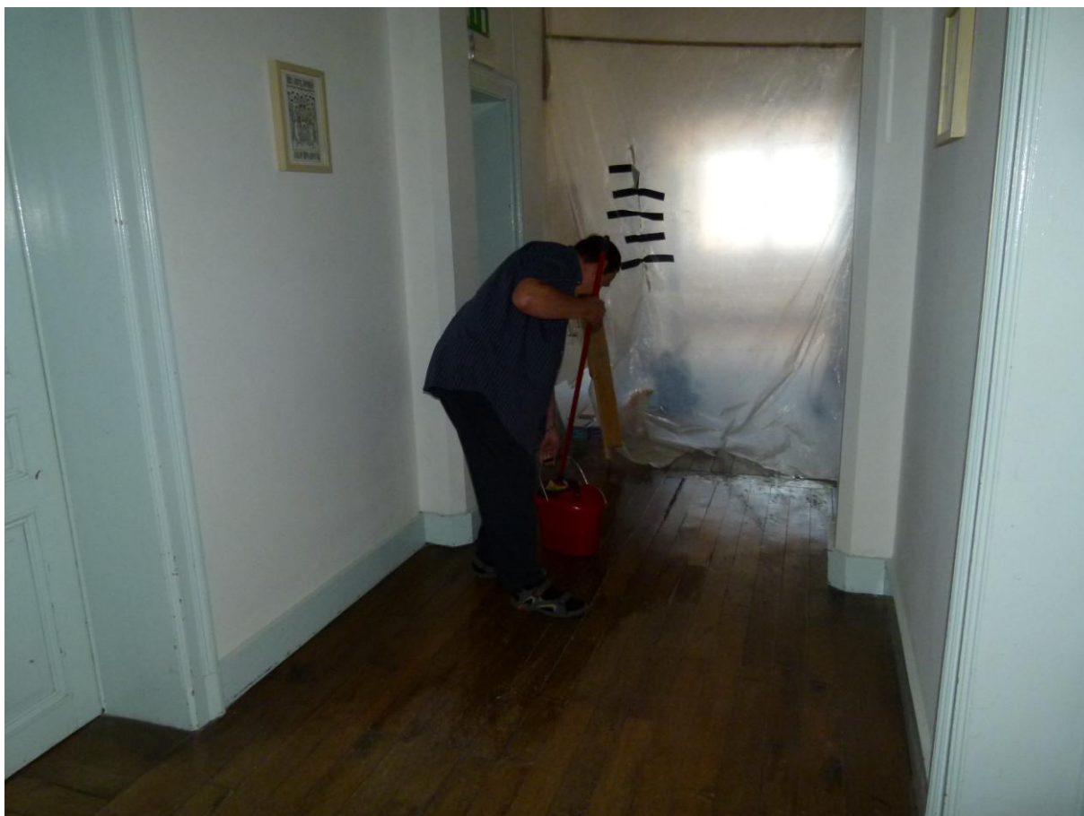
Un couloir vu sous un autre aspect (il faut protéger le nouveau parquet qui ne peut pas recevoir d'eau).
